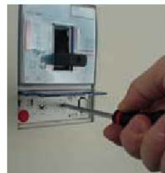
Réglage du seuil magnétique d'un disjoncteur DPX
